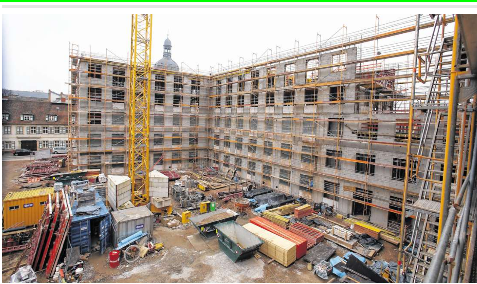
Blick aus dem Inneren des Quadrats B 6 in Richtung Schloss – neben dem Kran ist die Spitze der Jesuitenkirche zu sehen.
